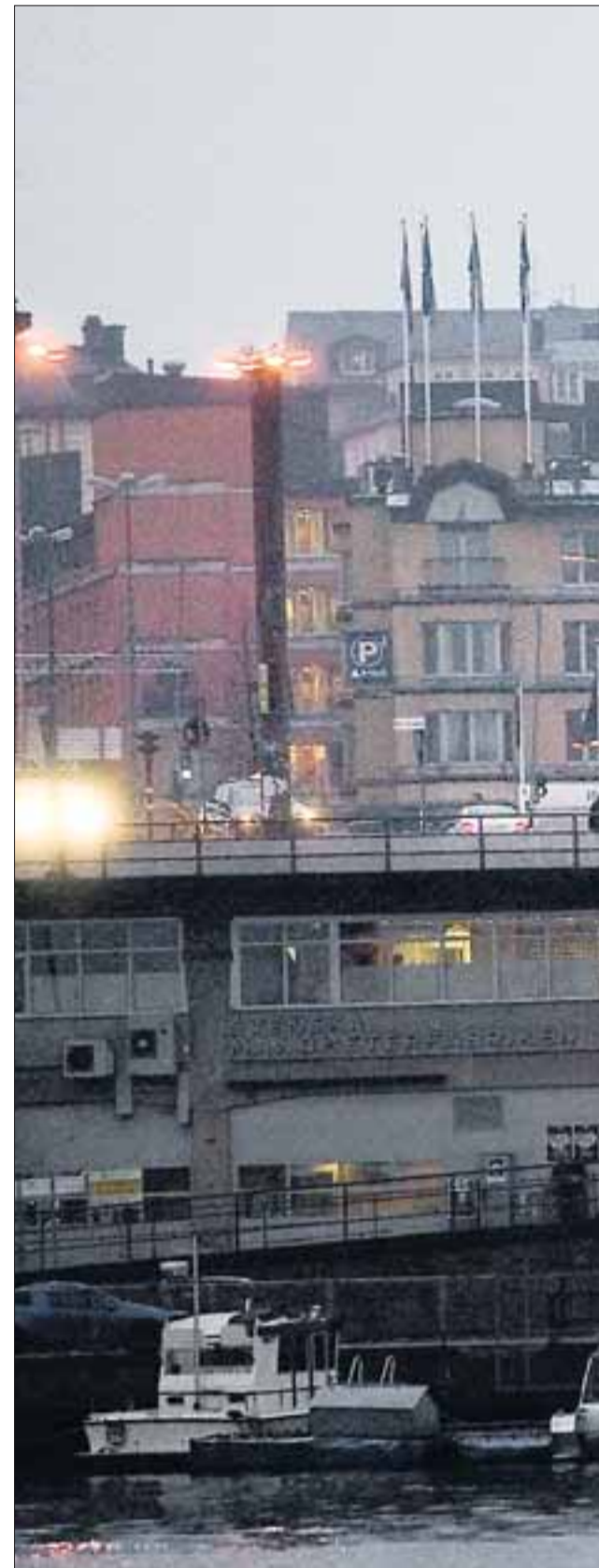
Slussen består av 24 brokonstruktioner och fogarna mellan alla
