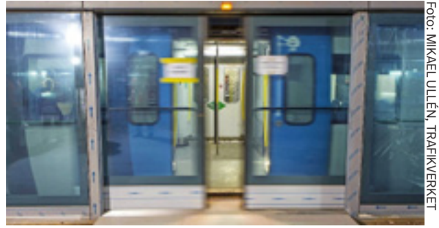
Så här såg det ut när plattformsbarrärer installerades på Citybanan – snart är det Åkeshovs tur.
