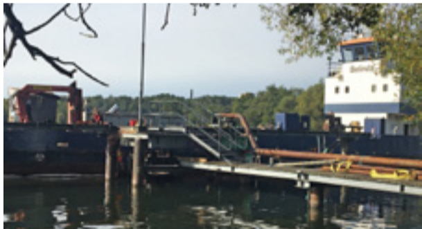
I fredags morse var alla båtar borta. På plats var det arbetsfartyg som jobbar med nedmonteringen av piren.
