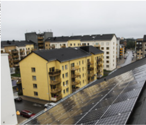
Under sommartid beräknas solpanelen kunna försörja nära hälften av de 270 hyresrätterna med el.
