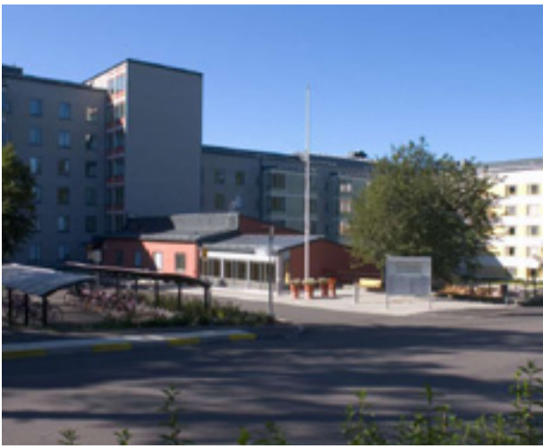
Solceller har installerats på Blackebergs gård, även kallat Mälarbackens vård- och omsorgsboende.
