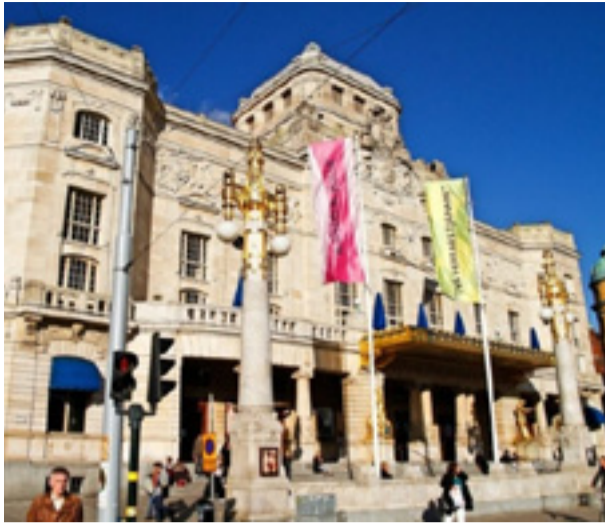
Dramaten stängde för renovering den 23 april i år. Nu är datumet för nypremiären satt. Foto: MOSTPHOTOS
