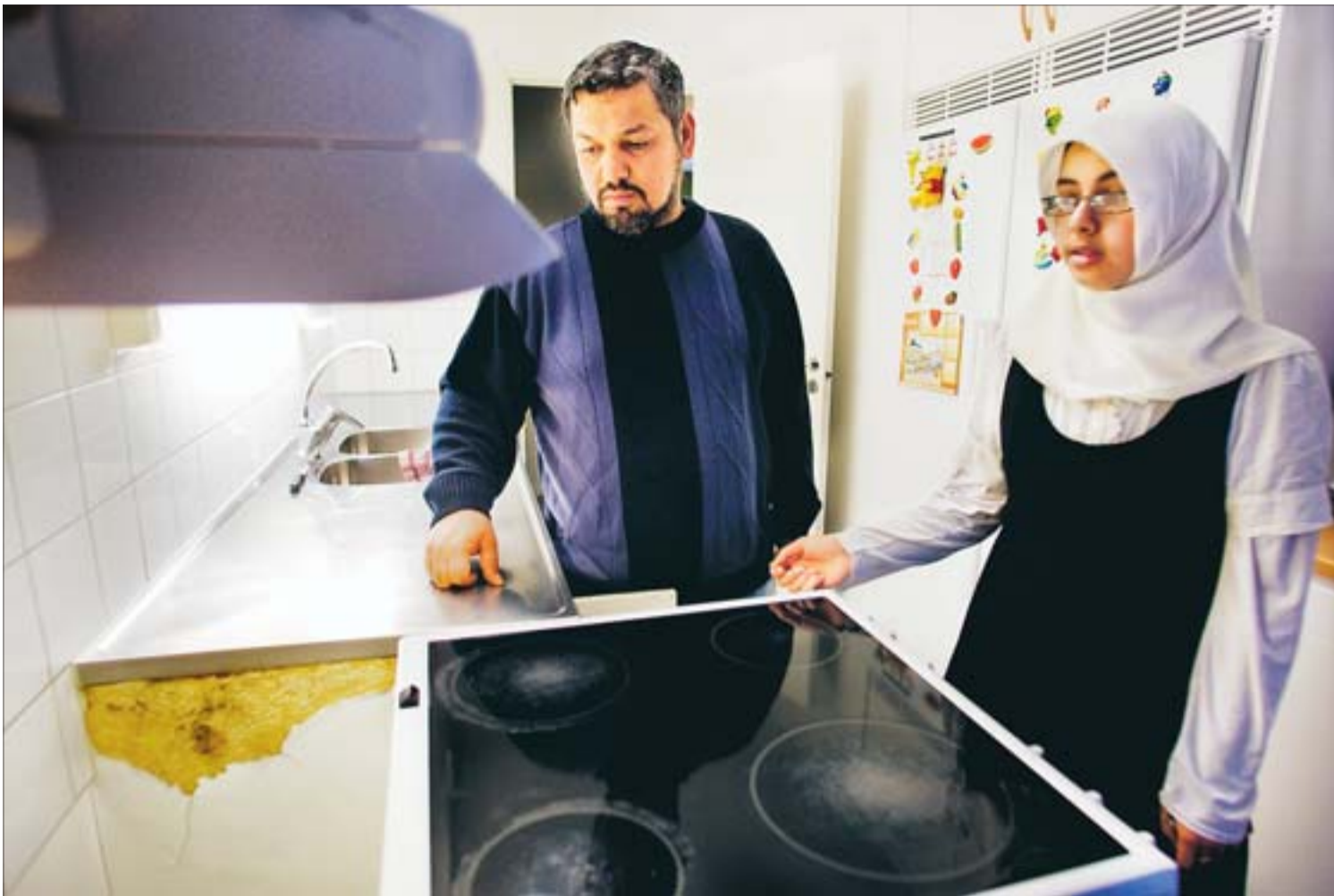
När Talib Hussain och dottern Sara drog ut spisen i köket såg de att spånskivan mot diskbänken hade flagnat och börjat vittra sönder. FOTO: NICKLAS THEGERSTRÖM
