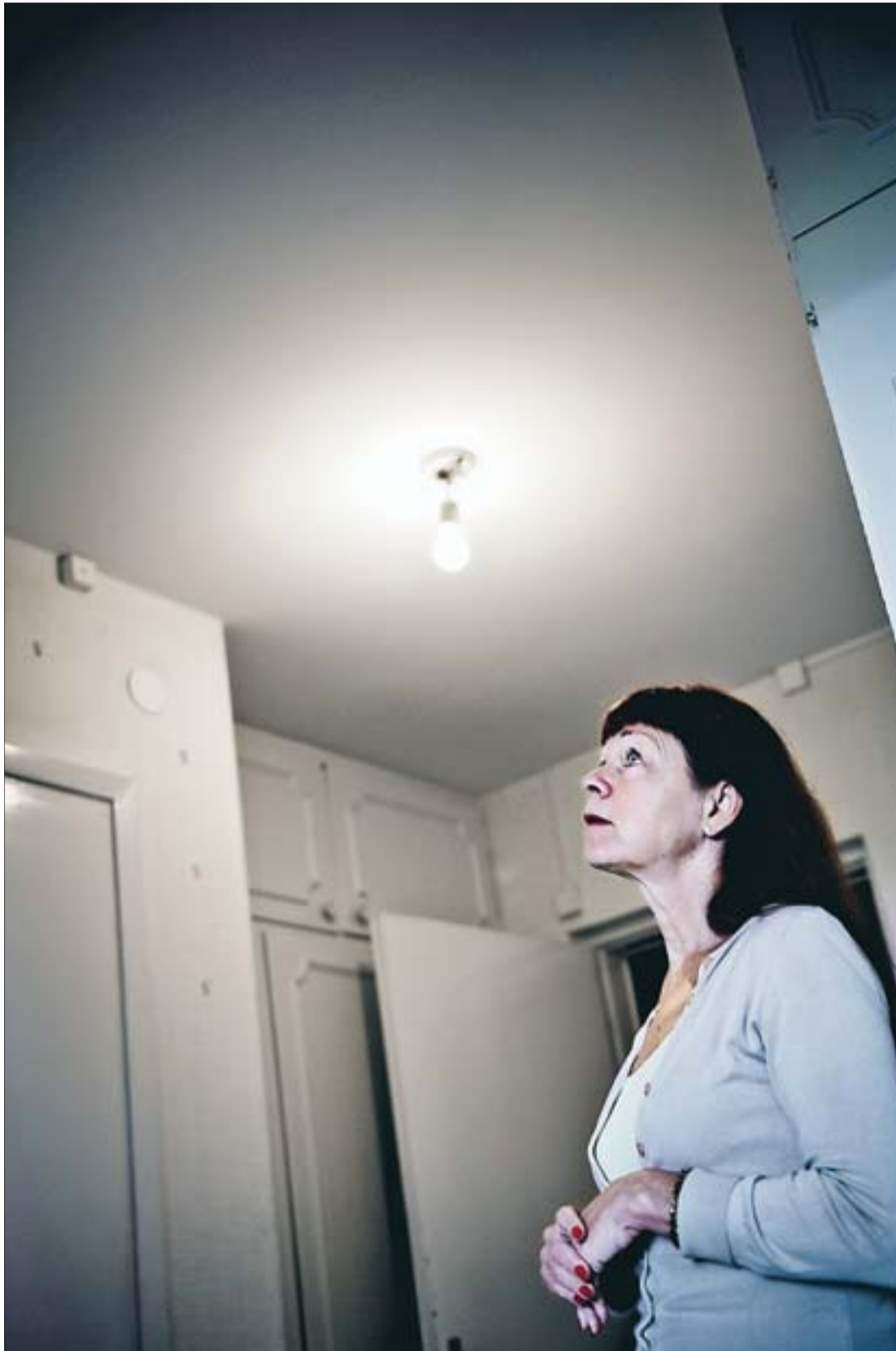
I dag är Siw-Marie Anderssons halltak nybyggt och nymålat. Men för en liten tid sedan fanns där inget tak över huvud taget. Däremot låg drivor av damm, cementbitar och grus på golvet.
