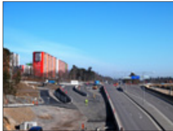
Vägarbeten i Flemingsberg.
